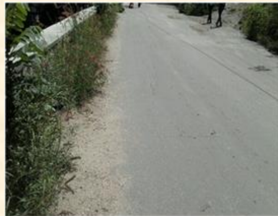
Fotografía 8. Segunda rehabilitación de la calle "Señor del pozo"
