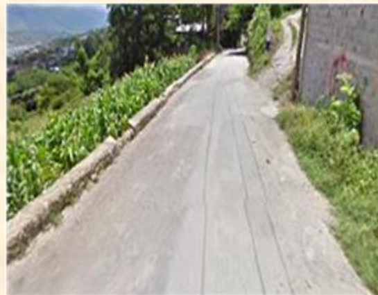
Fotografía 4. Rehabilitación del tramo carretera
