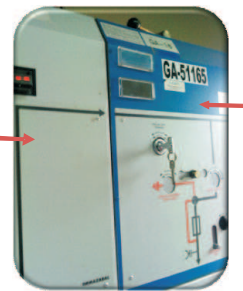
Control de aerogenerador anterior
