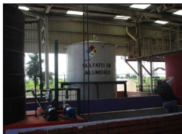
Fig. 3. Área de almacenamiento de reactivos químicos en la planta fisicoquímica.
