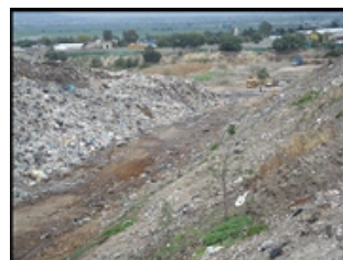
Fig. 8. Zona de traslape entre celda 1 y 2.
