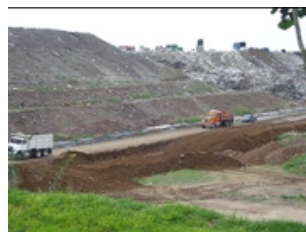
Fig. 7. Talud concluido de celda 1 -lado izquierdo- y frente de trabajo en celda 2 hacia el fondo-.
