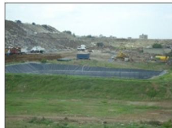
Fig. 1. Laguna de evaporación de lixiviados en el Relleno Sanitario de Tecamac.
