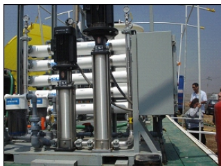
Fig. 5. Planta de tratamiento de ósmosis inversa con una capacidad de tratamiento de 30m 3 /día.
