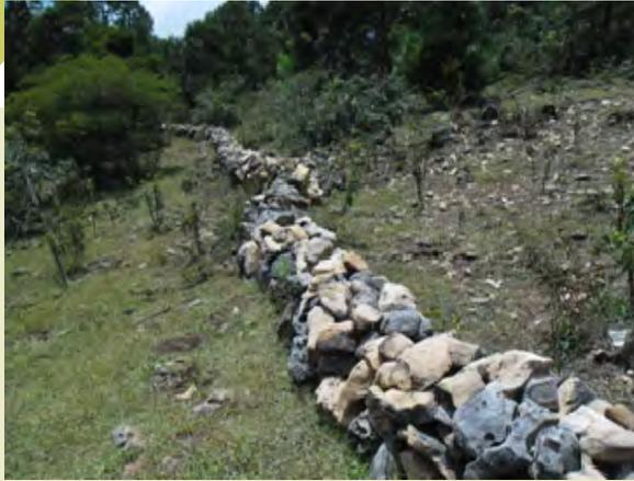
Figura 3. La barrera tiene un ancho de 40 cm., y 40 cm de altura, en curvas a nivel separadas a cada 25 m.
