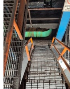
Figura 6. Escaleras del ingenio, Pujiltic, Chiapas
